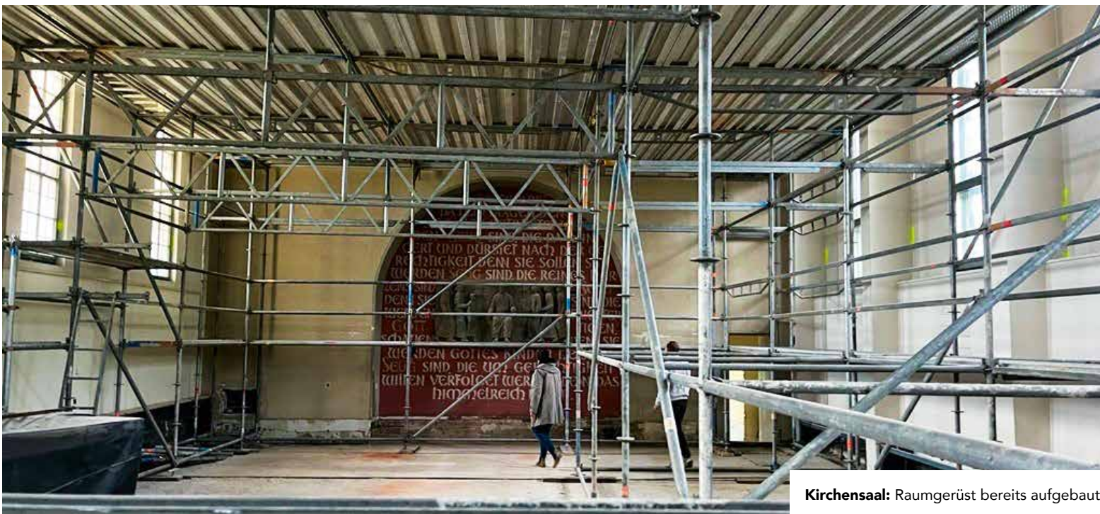
Kirchensaal: Raumgerüst bereits aufgebaut.
